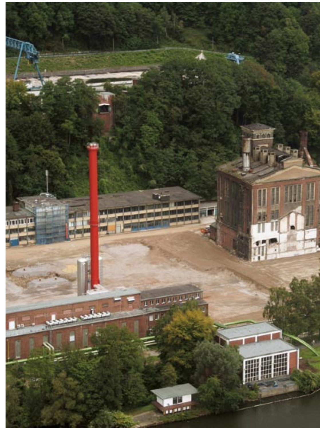
Tabula rasa 4. August 2005: Das alte Kraftwerk in Herdecke ist vollständig abgerissen, der Standort geräumt. Alles ist bereit für ein GuD-Kraftwerk neuester Bauart.
