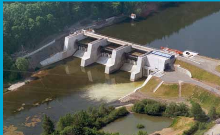
Die Laufwasserkraftwerke Wahnhausen (Abbildung oben) und Affoldern gehören zum Kraftwerksverbund Werrawerk.
